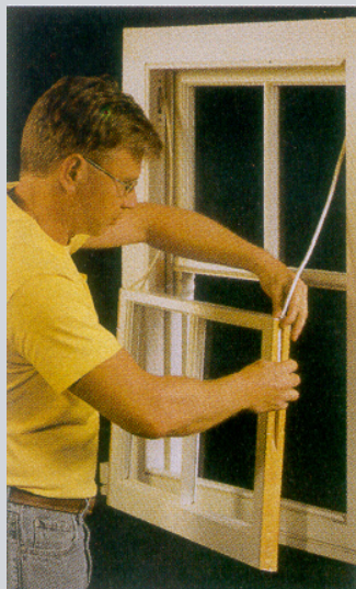
Die Schiebeflügel sind mit Spezialbeschlägen und Seilzügen geführt
