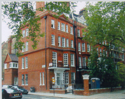
Für dieses 5-geschossige Stadthaus wurden 61 Vertikal-Schiebefenster nach strengen Denkmalschutz-Auflagen hergestellt
